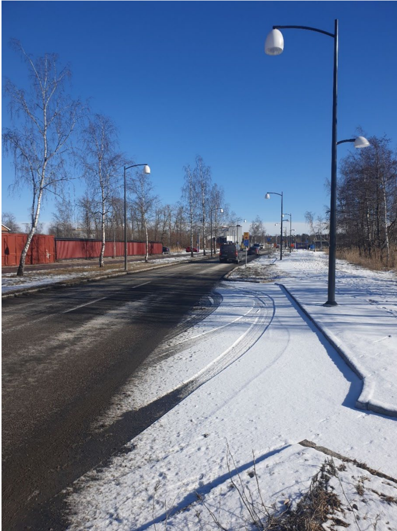
Figur 2. Sörbyängsvägen efter ombyggnation till Stadsgata
