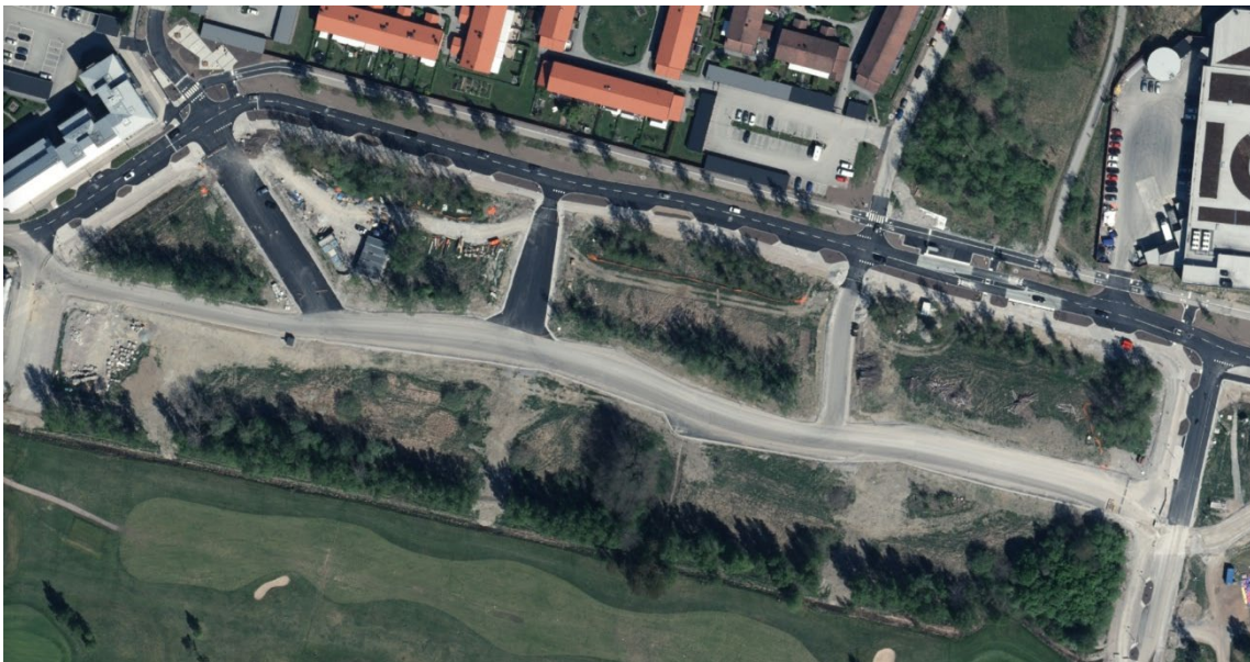
Figur 3. Översiktligt foto av Sörbyängsvägen och Sörbyvägen med den tillfälliga byggvägen Tamarindvägen ((framtida gångfartsområdet) som löper genom området
